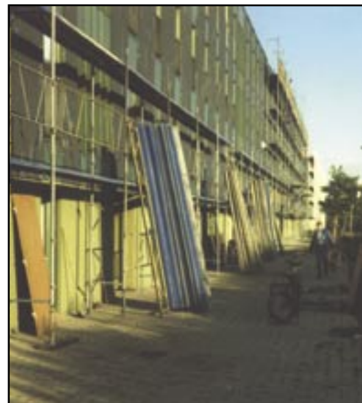
I 1985 fandt den sidste store renovering sted. Dengang blev der lavet tag og nye opgangsvinduer. Foto: arkiv.
