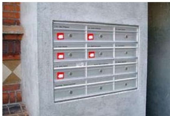
Postkasserne bliver muret ind i murstensvæggen. Foto: Juliana
